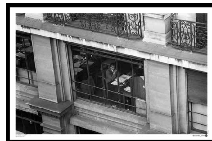
18 Immeuble de bureaux. 1960
